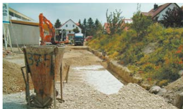
Укладка и утрамбовка верхнего слоя поверхности для проезда автотранспорта, под которой установлена система инфильтрации
