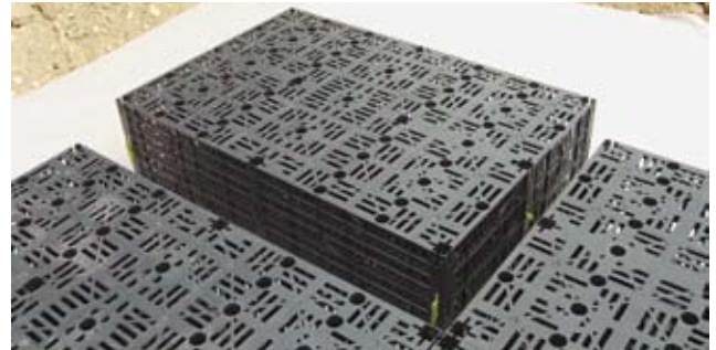
А. Соедините секцию DRAINFIX BLOC к уже установленным блокам соответствующими сторонами, используя соединительный крючок.
