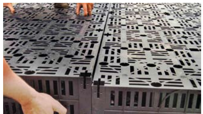
Д. Опустите блок DRAINFIX BLOC, после этого он будет надежно зафиксирован от сил выталкивания.
