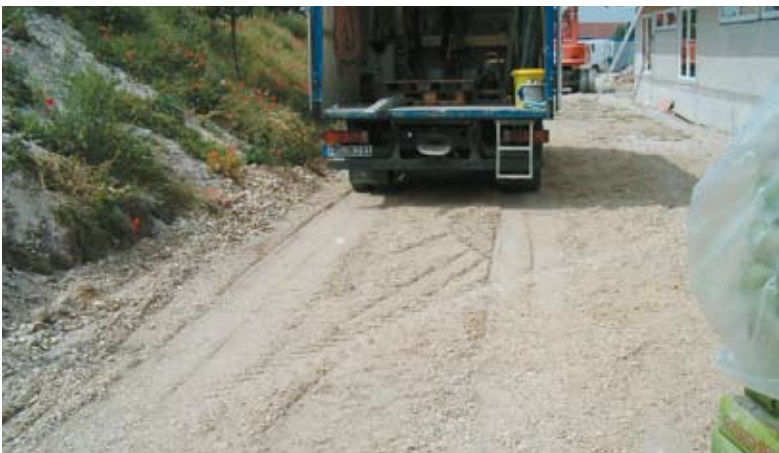
Покрывающий слой толщиной 50 см позволяет проезд транспорта с максимальной нагрузкой 12 тонн
