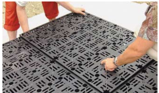
С. Зацепите соединительные крючки, немного приподняв блок и придвигая его к уже установленным блокам.
