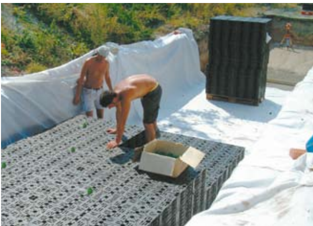
Укладывание нескольких слоев модулей с соединительными элементами
