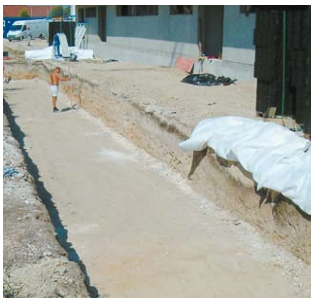
Котлован с гравийной засыпкой
